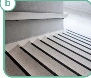
Merdivenlere kaydırmaz bant yapıştırılması
